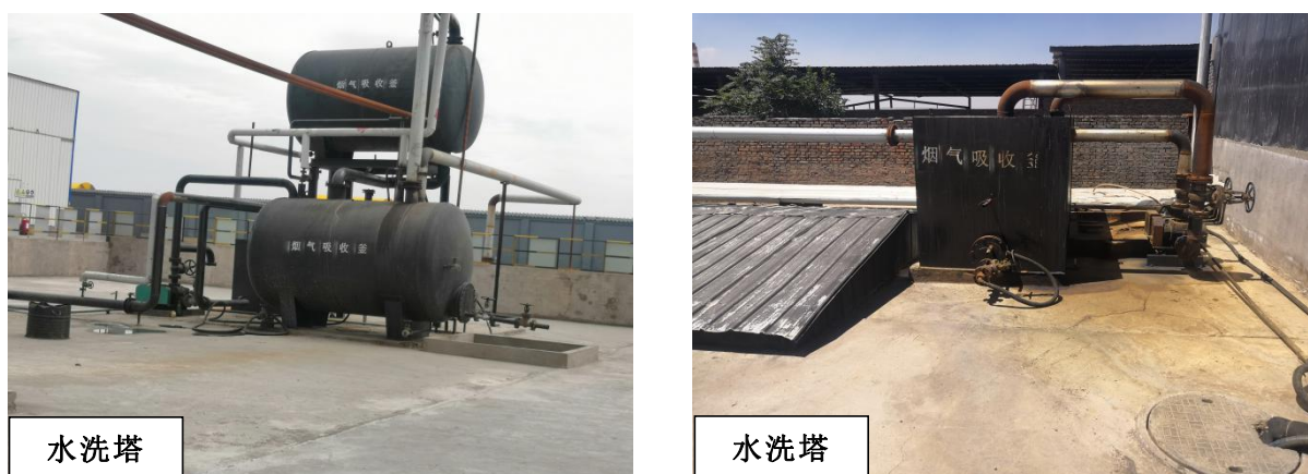
图 4.2-1 储罐区及装置区废气治理措施
