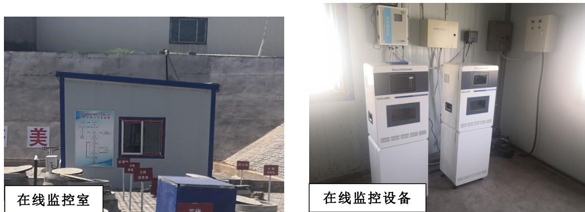
图 4.3-2 项目废水在线监测室及在线监测设备
