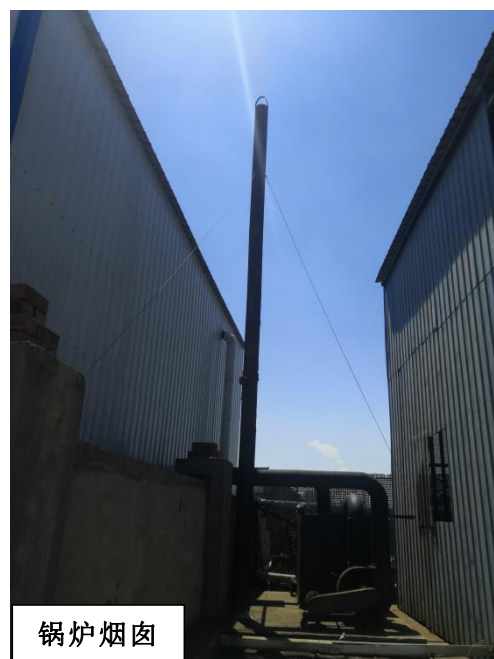
图 4.2-3 项目导热油炉及排放烟囱
