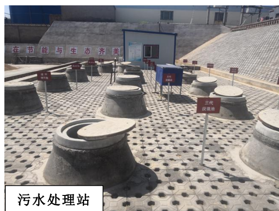
图 4.2-4 项目污水处理站加盖密闭图
